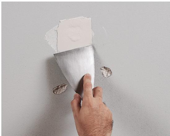
El paramento debe encontrarse limpio, en buen estado de cohesión y con una planeidad suficiente para que la adhesión de los paneles sea la correcta.
