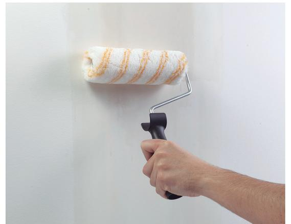
La aplicación directa del sistema sobre paramentos poco cohesionados o pulverulentos podría derivar en el colapso del mismo.
