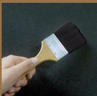
Aplicar el barniz final (PROTECTOR OXITEM o SELLADOR INTERIOR OXITEM), según se trate de exteriores o interiores, al uso. Aplicación con paletina ancha, rodillo o pistola.
