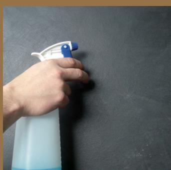
Aplicar una mano de ACTIVADOR OXITEM al uso, y esperar 30 - 120 minutos. Aplicar una segunda mano de ACTIVADOR OXITEM y dejar secar 24 horas. Aplicar preferentemente con paletina ancha o pulverizador.
